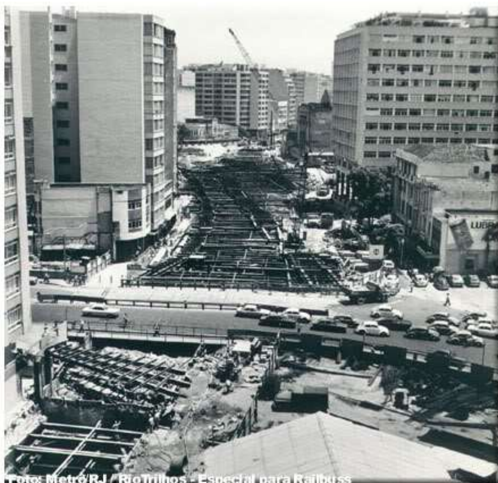
Figura 31: Obras da Estação do Largo do Machado
