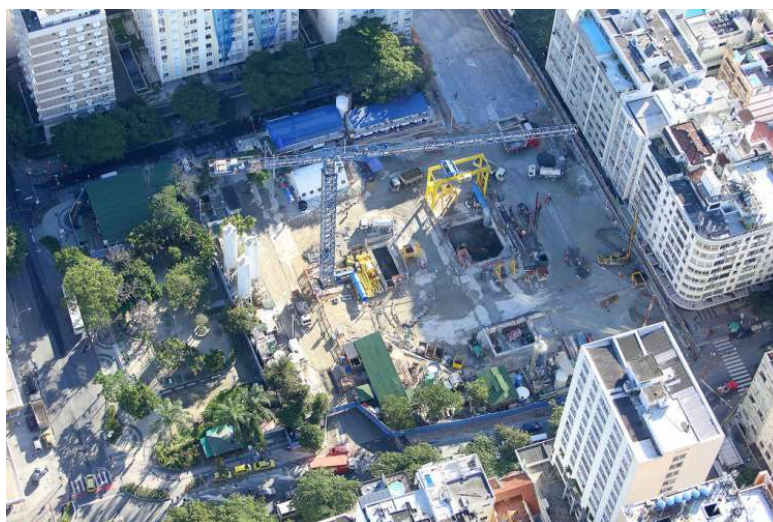
Figura 33: Canteiro de obras na Praça Antero de Quental
