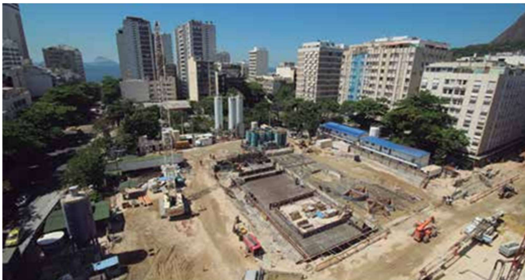
Figura 56: Praça (e estação) Antero de Quintal – escavação da laje de acesso
