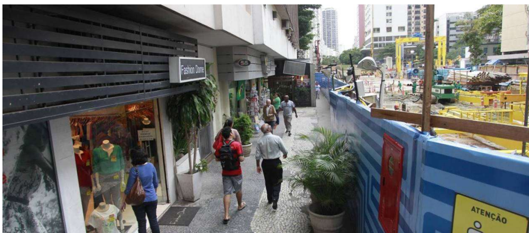
Figura 55: Comerciantes do Leblon se queixam das obras da Linha 4 do Metrô
