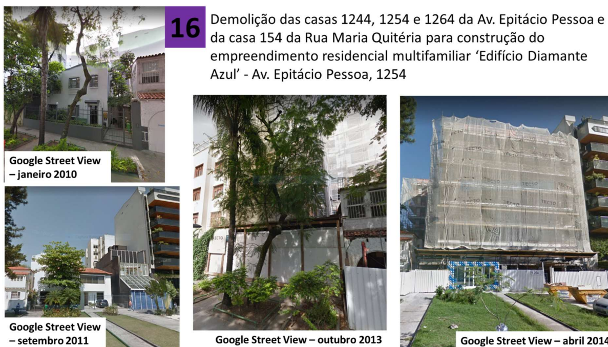
Figura 363: IPA 16 – Demolição de casas (1244, 1254 e 1264) para construção de residencial multifamiliar
