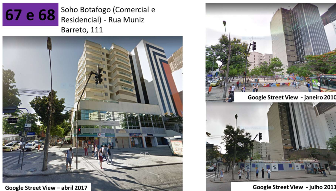
Figura 252: BOT 67 e 68 - Soho Botafogo (Comercial e Residencial) - Rua Muniz Barreto, 111 – em janeiro de 2010, julho de 2011 e abril de 2017
