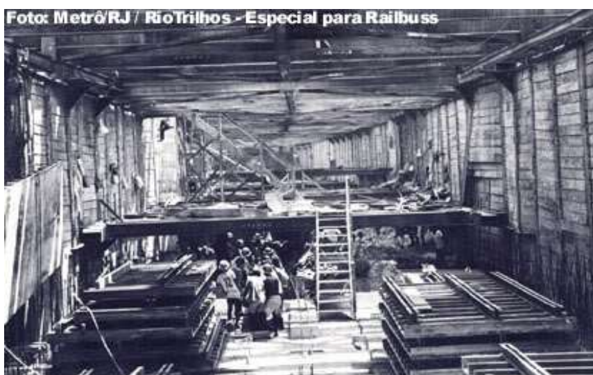
Figura 28: Operários na construção do Metrô, no Jardim da Glória (1975)
