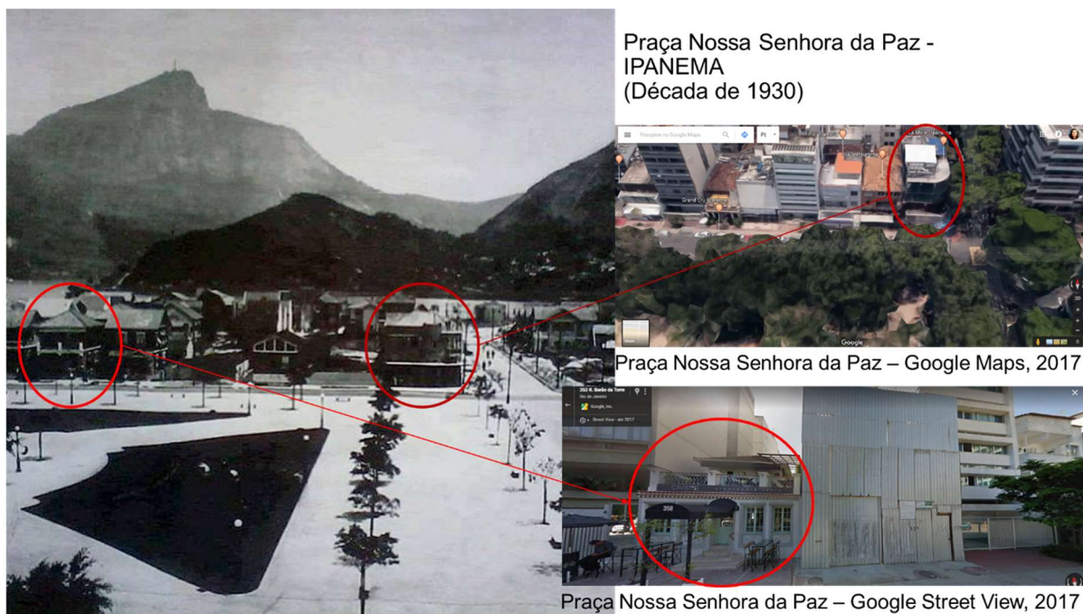
Figura 21: Identificação de permanências de edificações antigas em imagens captadas pelo Google Maps e Google Street View
