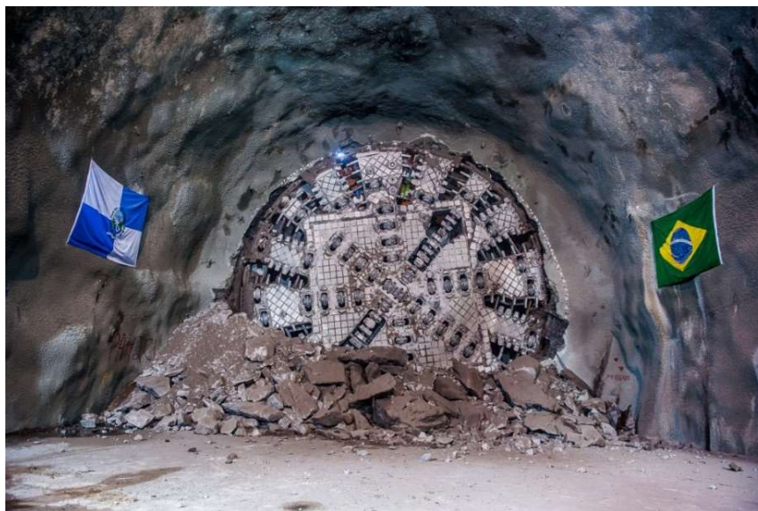
Figura 34: Conclusão da escavação da linha 4
