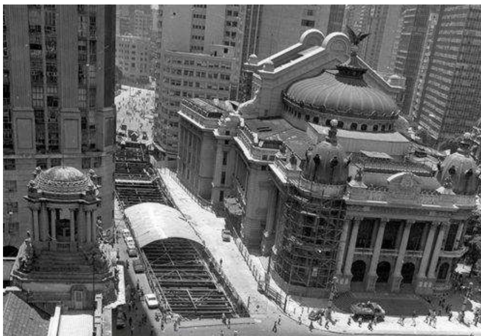
Figura 29: Obra do metrô no trecho Centro-Botafogo
