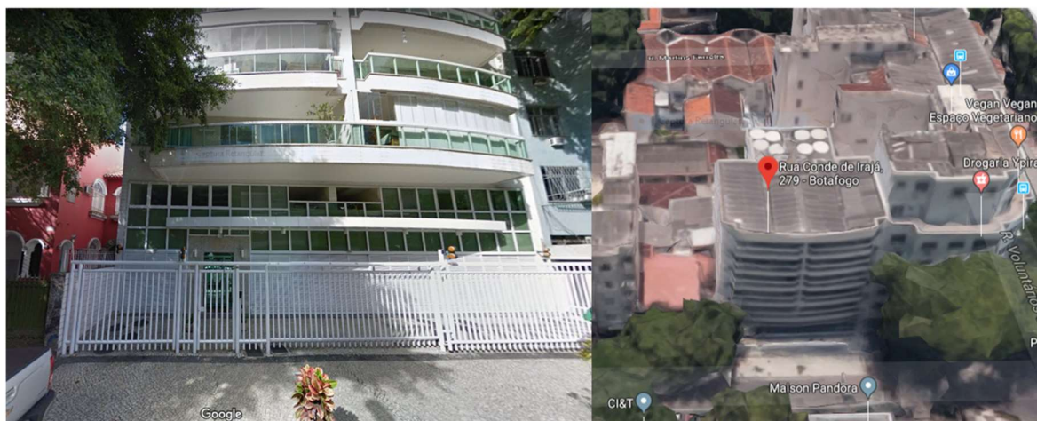
Figura 150: BOT 34 – Residencial à Rua Conde de Irajá, 279
