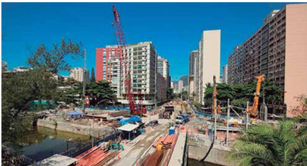
Figura 57: Jardim de Alah – paredes diafragma da nova estação
